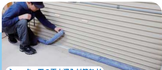
シャッター下の雨水浸入対策など
